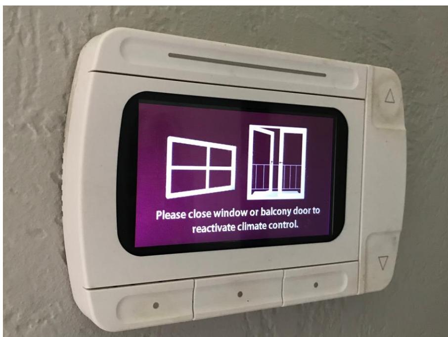
Gambar 18. Kontrol mati otomatis untuk AC berdasarkan ventilasi alami
